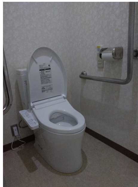
1階トイレ③
