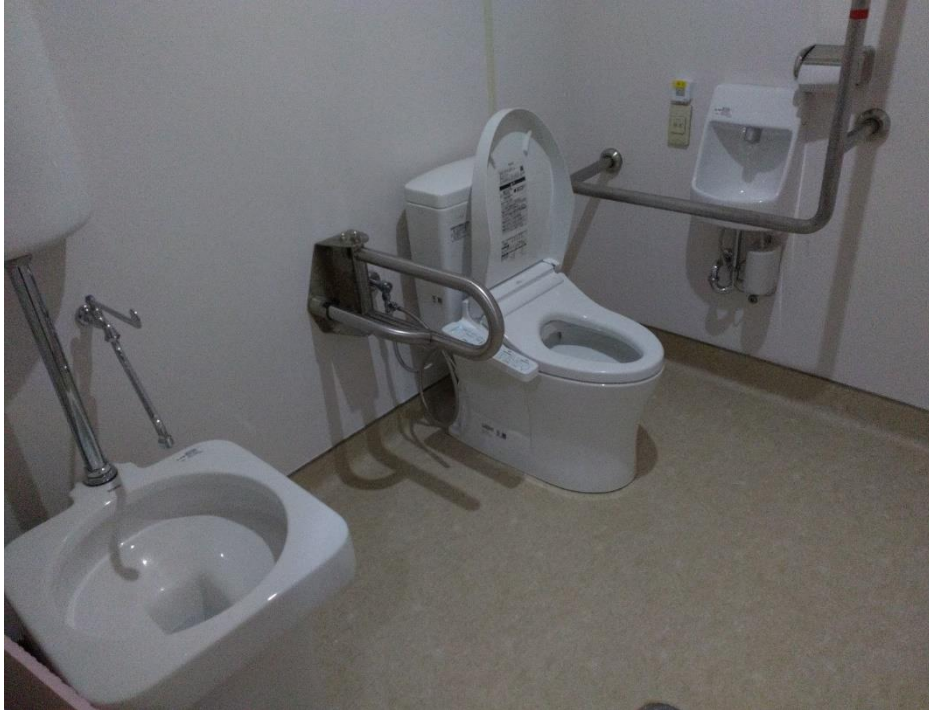
1階トイレ①
